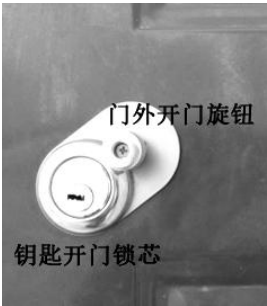
图 7: 门外开门旋钮和锁芯
